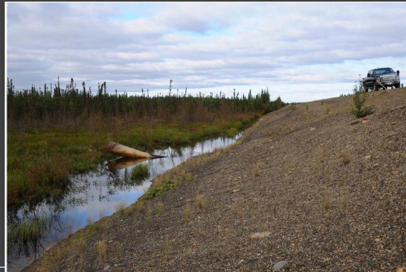
Peel Plateau – accumulation d'eau et dégradation d'un ponceau au km 90, Yukon (EBA, 2013)
